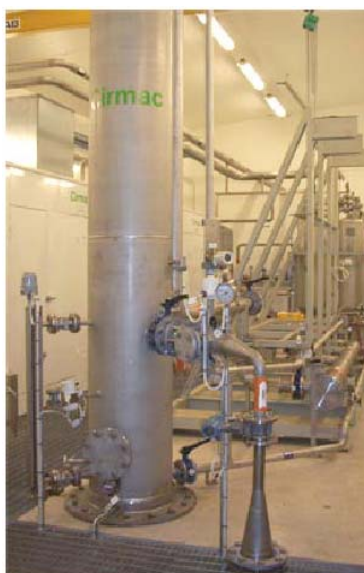
Figure 24 - Unité d'absorption chimique (traitement de 300 m 3 /h à Boras - Suède) [13]
