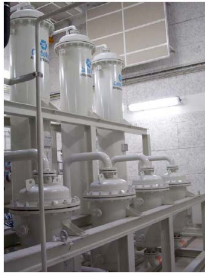
Figure 22 - Procédé PSA (traitement de 350 m 3 /h à Helsingborg - Suède) [13]
