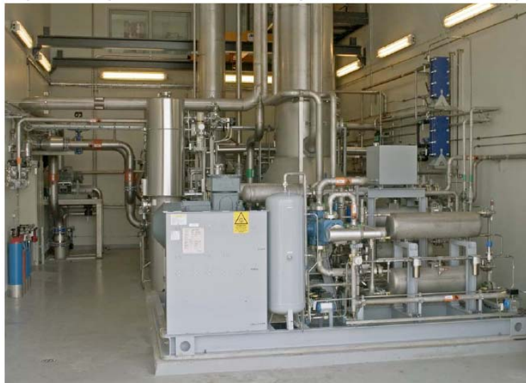
Figure 23 - Procédé de lavage à l'eau (traitement de 600 m 3 /h à Stockholm) [13]
