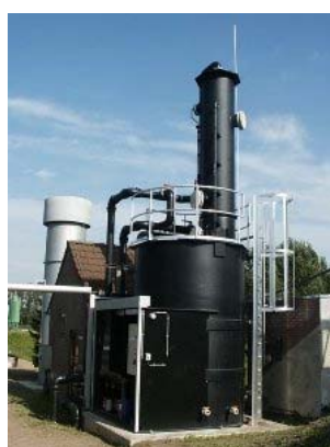
Figure 34 - Procédé biologique THIOPAQ ® de désulfuration du biogaz (Paques)
